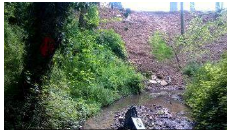
Rougeat au Perrat, remblai néfaste en rive gauche
