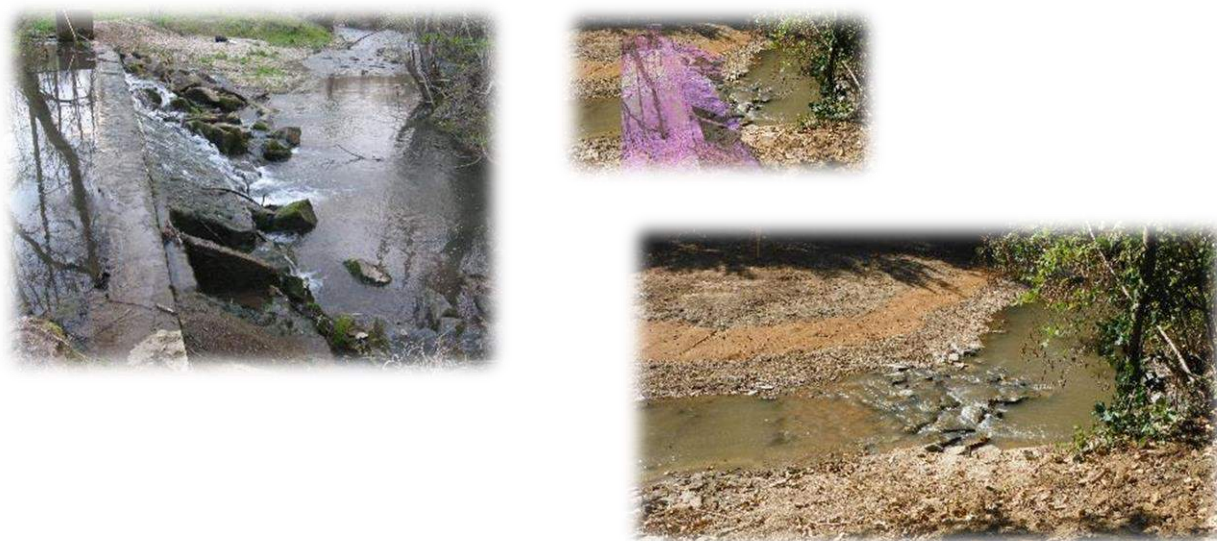
Figure n°III.52. Seuil des Charmes avant et après travaux
