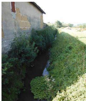
L'Appéum aval immédiat RD933
